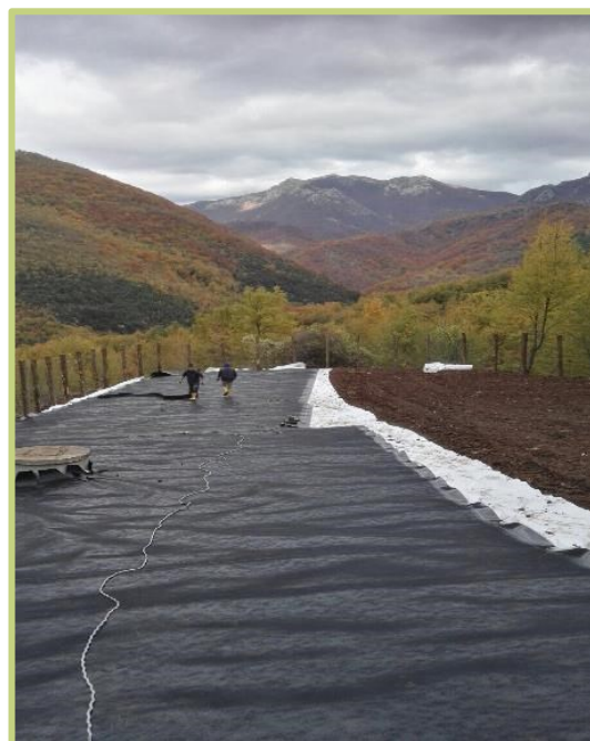
Foto: Messa in sicurezza della discarica di Filettino (FR)
