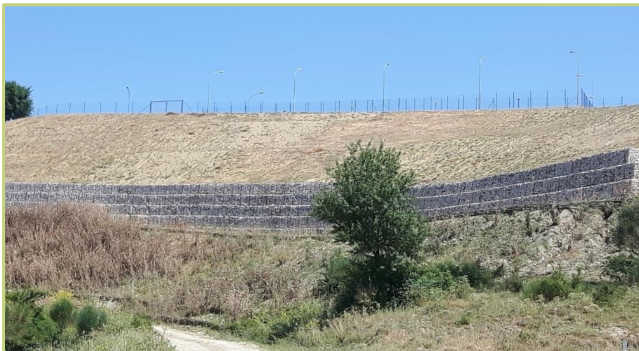
Foto: Messa in sicurezza della discarica di Andretta (AV)
